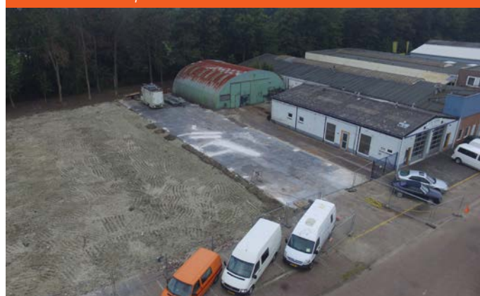
Het complete bedrijf is gesloopt en er wordt gewerkt aan een nieuwbouwplan
